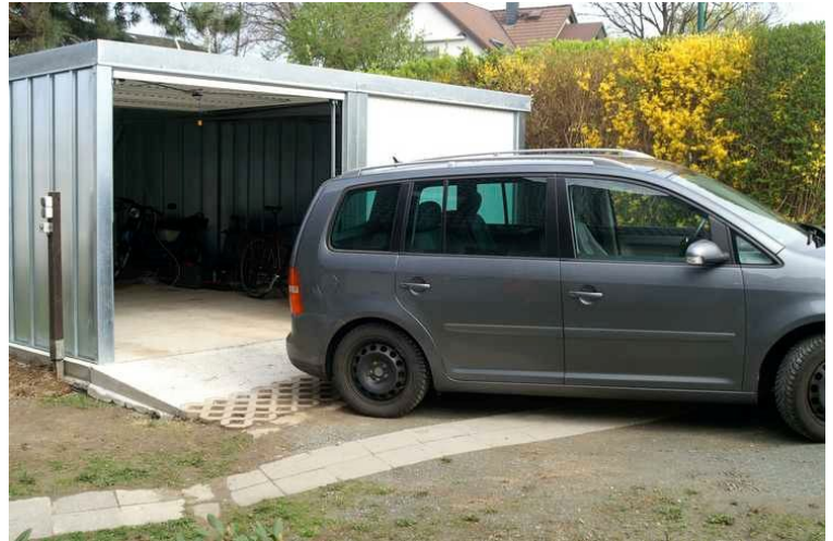
Garagenrampe: Gut geplant und vor Schimmel bewahrt
