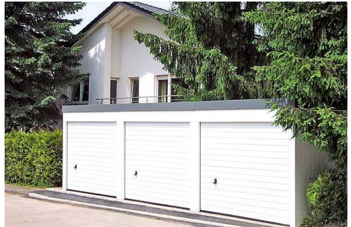
Gut belüftet und gut einbruchgesichert: MC-Garagen
