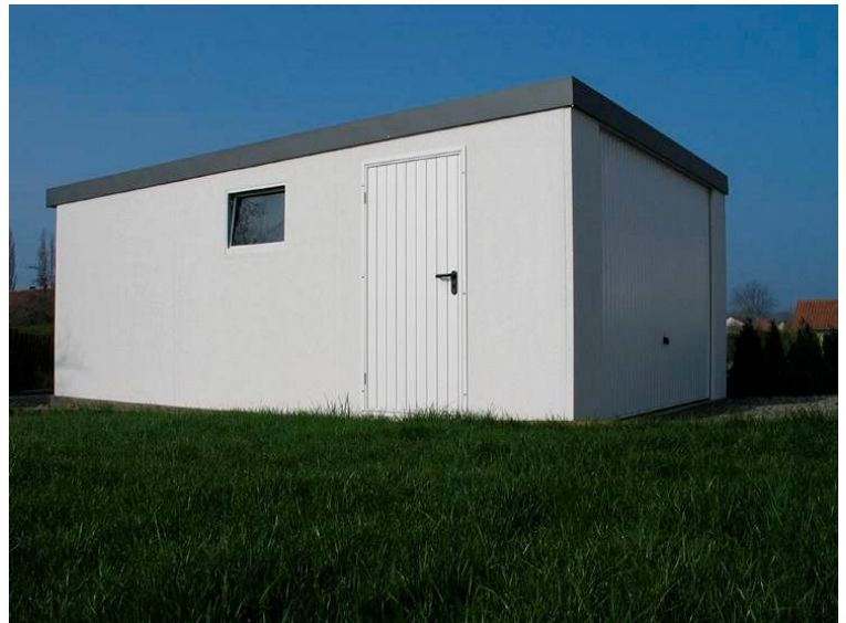
Garagenrampe: Licht und Luft für trockene Garagen
