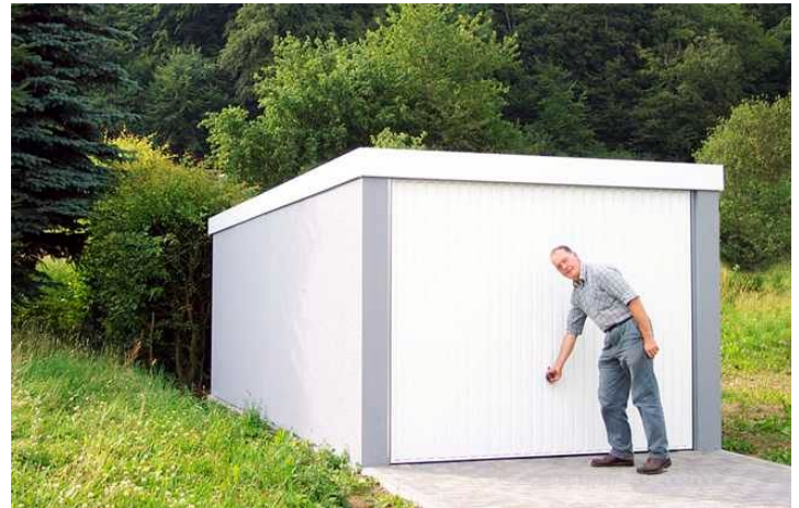
MC-Garagen: Trocken und sicher aufgehoben
