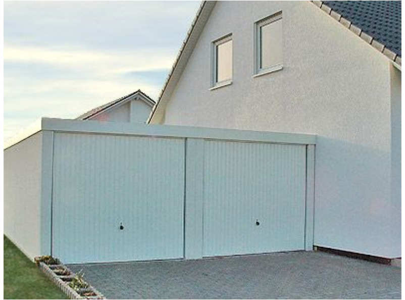
Richtig gebaut ist halb gelüftet: Exklusiv-Garagen
