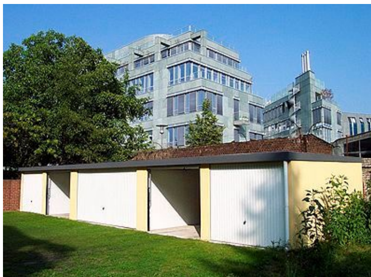
Platz für Solarpanele auf dem Garagendach
