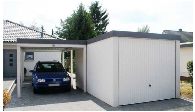
Mit MC-Garagen.de rechtssicher bauen
