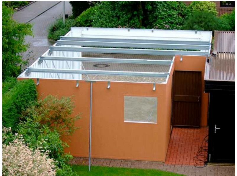
Aufbau in wenigen Stunden durch Garagenrampe.de
