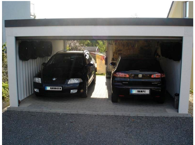
Zentimetergenau im Garagenbau
