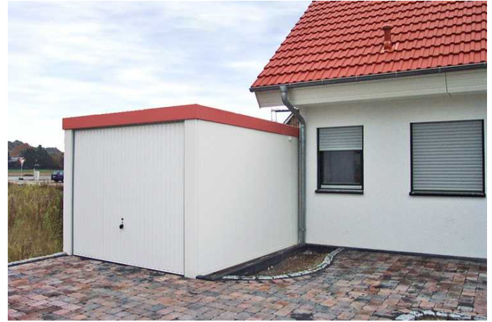
Zweckdienlicher Garagenbau mit MC-Garagen aus Mannheim
