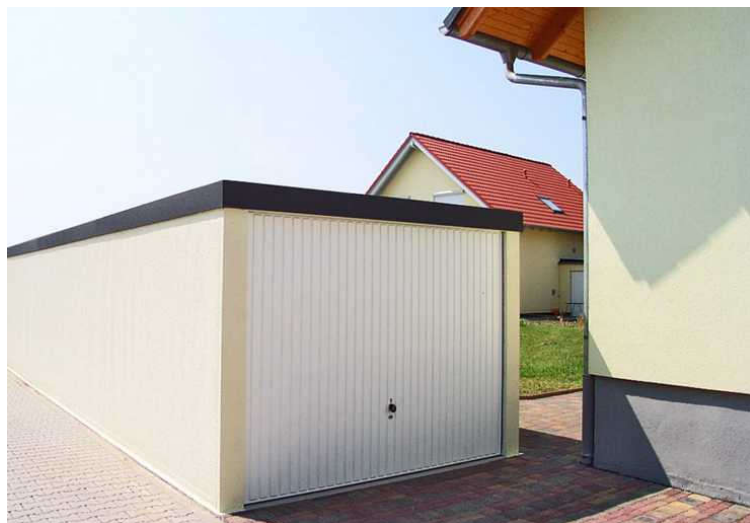
Gut gesicherte MC-Garage mit Hörmann Garagentor
