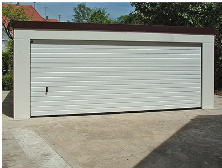
Exklusiv-Garage und Garagentor mit Aufschiebesicherung
