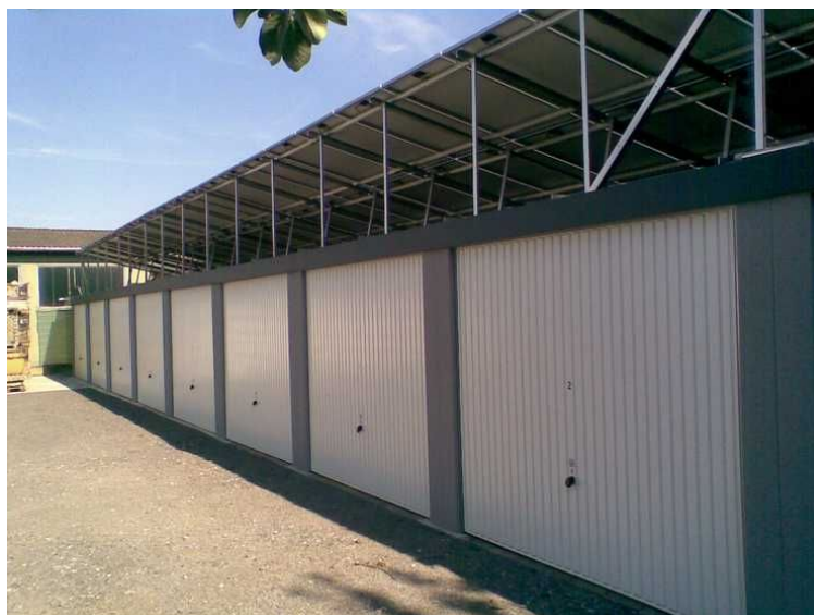
Solaranlagen auf Garagendächern von Garagenrampe.de
