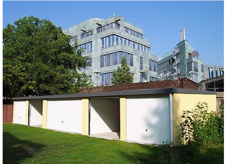
Harmonisch eingefügt ins bauliche Umfeld: Exklusiv-Garagen
