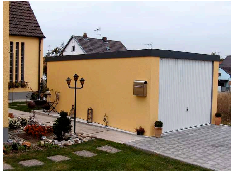
Brandschäden vermeiden: Garagentor schließen
