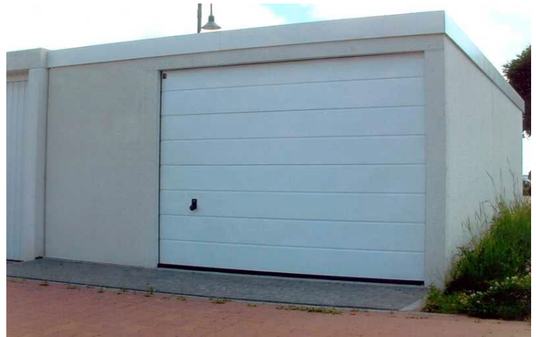
Passgenau und bedarfsgerecht: Garagenrampe
