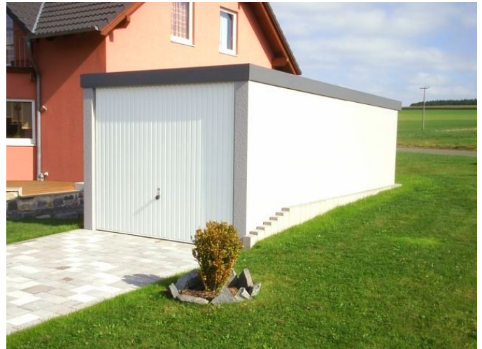
Exklusiv-Garagen: Schutz vor Oberflächenwasser in Hanglagen
